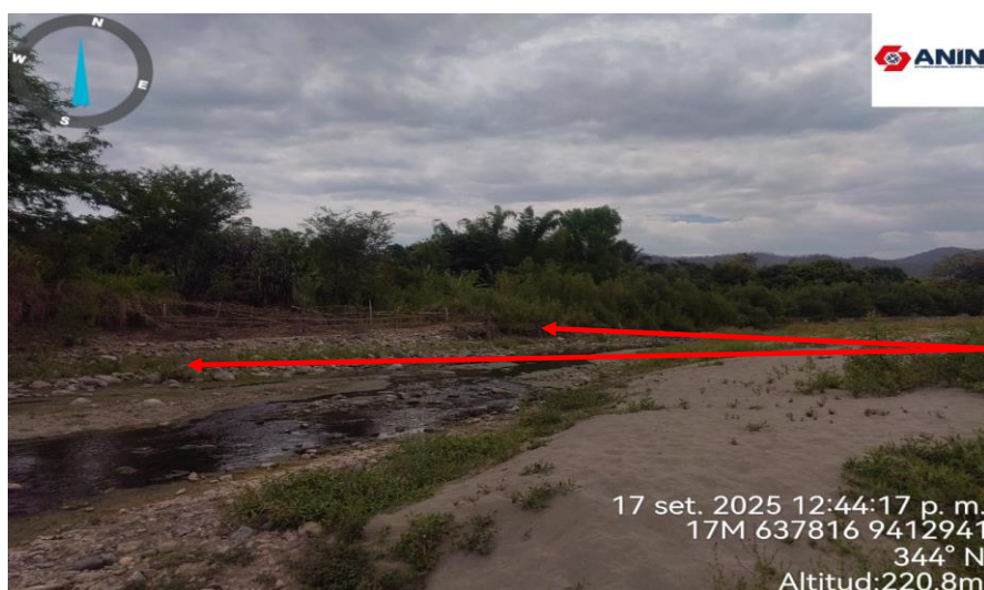
FIGURA N°02: TRAMO CRÍTICO EN EL RIO BIGOTE MARGEN IZQUIERDA AGUAS ABAJO EN EL SECTOR DOTOR, EN LA CUAL LA ESTRUCTURA HIDRAULICA SUPLEN SU FUNCION Y EL AREA SE ENCUENTRA COLMATADA AFECTANDO TIERRAS AGRICOLAS Y POBLACION, DISTRITO DE SAN JUAN DE BIGOTE, PROVINCIA DE MORROPON - PIURA.
